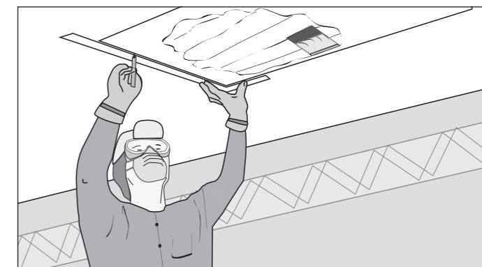
Fig. 7 Dessiner un rectangle de la taille de l'ouverture du plafond.
