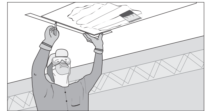
Fig.7. Dibuje en el techo un rectángulo del tamaño de la abertura preliminar, con el borde en paralelo a una de las vigas.
